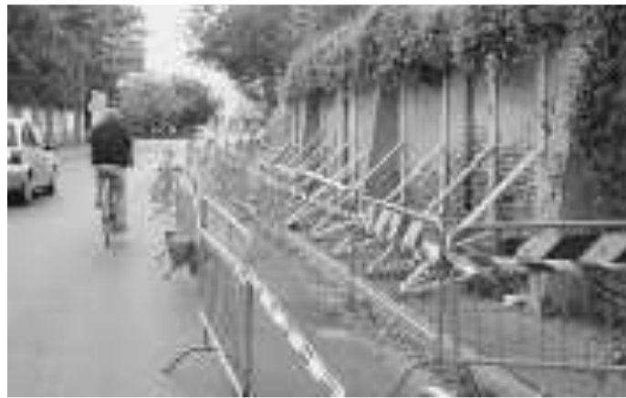
Ora servirà al più presto un'opera di consolidamento
